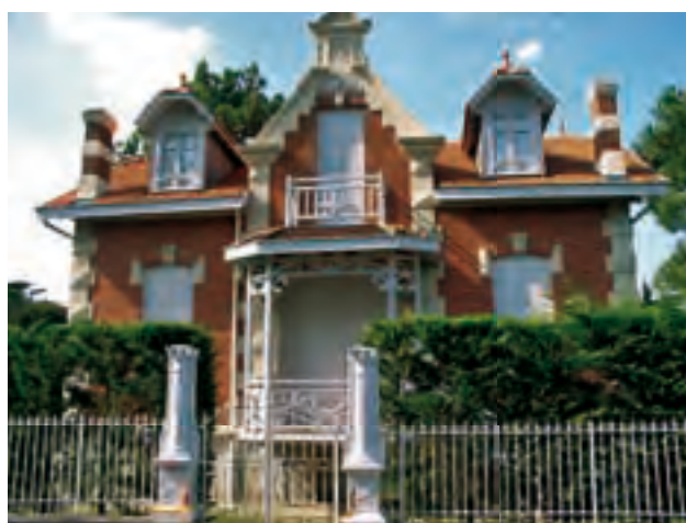
Villa Belle Époque, Souillac-sur-Mer
